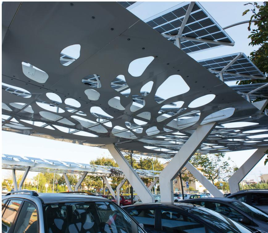
L'intervento ha realizzato, ai margini dell'area target, un sistema bipolare di infrastrutture tecnologiche formato da due stazioni di produzione energetica fotovoltaica attrezzate con otto infrastrutture di ricarica (sei per auto, due per bici) per alimentare i mezzi ZEV (Zero Emissions Vehicle) utilizzati dal Comune, da utenti privati e per il bike sharing.
